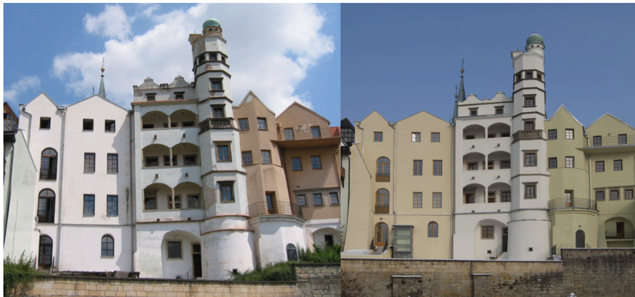
Fasády muzea před opravou. Pohled z jihu. Fasády z jihu po opravě – listopad 2012.
