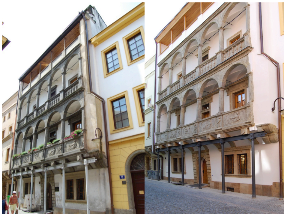
Renesanční kamenné arkády Mydlářovského domu před a po opravě. Pohled z ulice na vstup do muzea.
