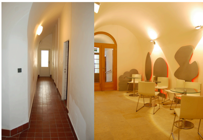
Chodba vedoucí na terasu muzea – před a po rekonstrukci.
