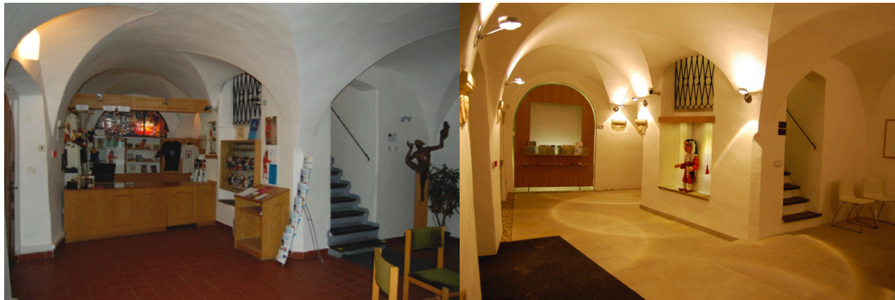
Oprava přízemí čp.74 a čp.75
